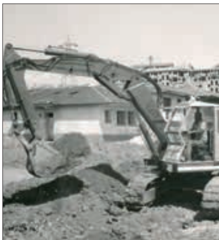
1976: S 517 con telaio cingolato e cabina in plastica nel movimento terra
