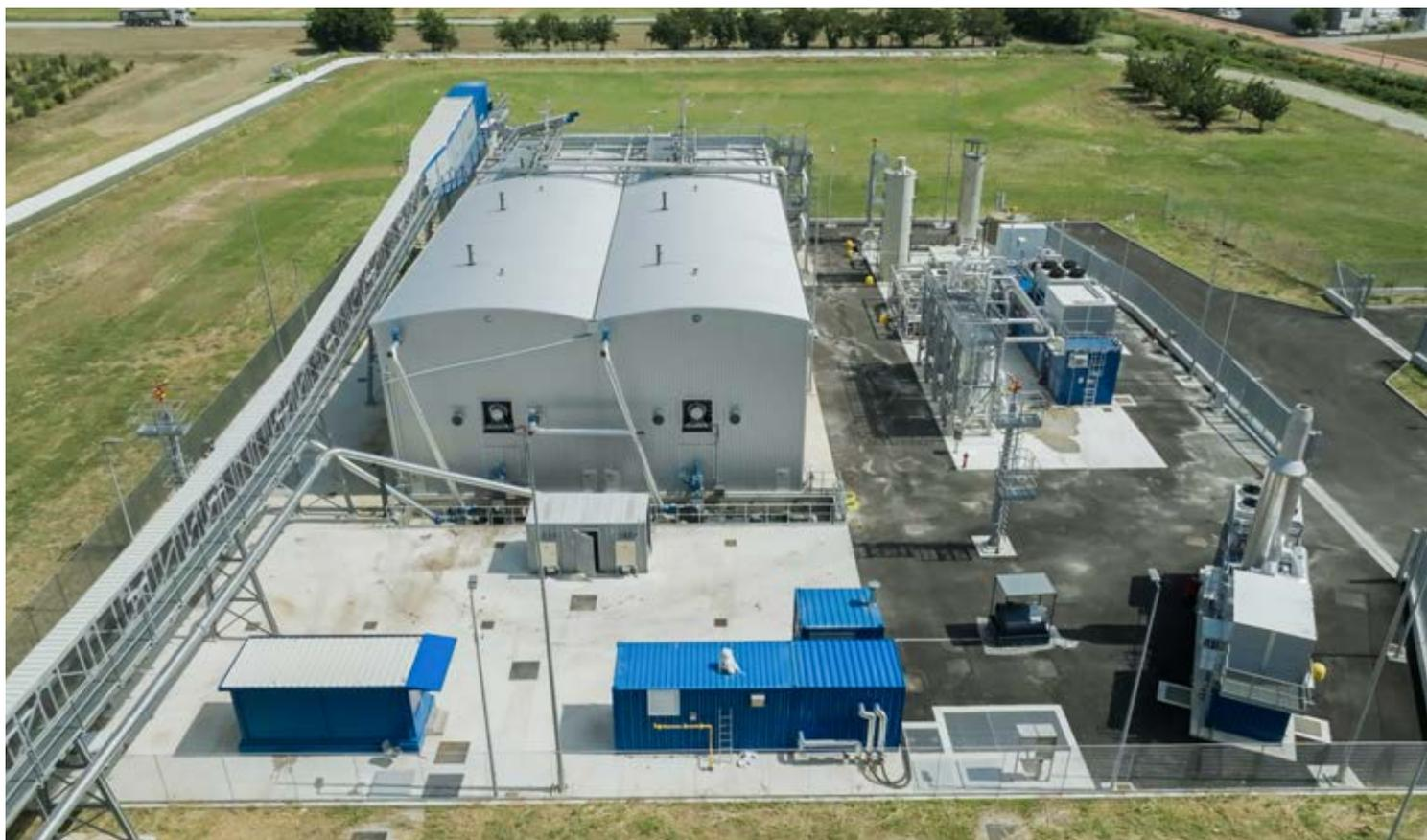
compost di qualità e biometano per il rifornimento dei mezzi di raccolta. L'ampiamiento del sito di Trevignano consente il trattamento anaerobico di 47mila tonnellate/anno di rifiuto organico per la produzione di biometano pari a 527 Smc/h. L'impianto prevede una produzione di biogas pari a 7,6 milioni Nmc annui, che viene poi trattato e purificato per ottenere biometano (liquido e compresso) per autotrazione e immissione in rete.
